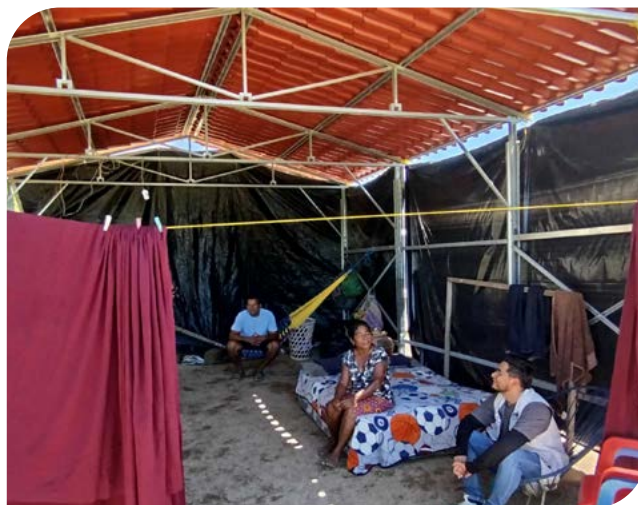
Visita a campo con nuestro aliado CADENA en las comunidades del sur de Oaxaca, donde se construyeron techos para las familias afectadas por el Huracán Erick
